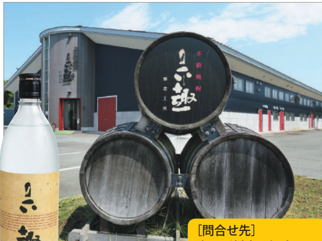
太陽光発電システムも導入している
