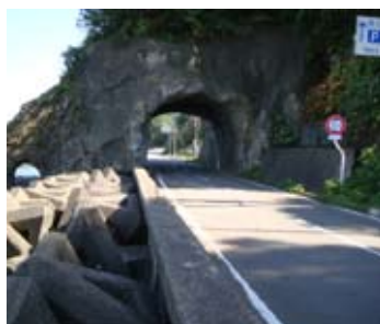
国道339号線に残る親子洞門
