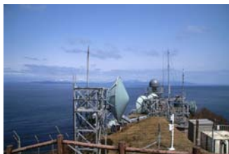
龍飛崎の高台にて、海上自衛隊の通信施設。彼方に北海道松前半島の山並みが見えている。
